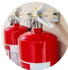
Szkolenie z ochrony przeciwpożarowej i ewakuacji pracowników
