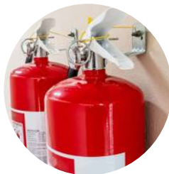
Szkolenie z ochrony przeciwpożarowej i ewakuacji pracowników
